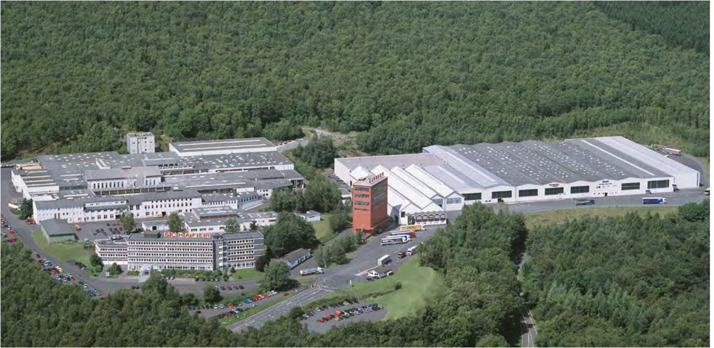
Hauptverwaltung Werk Neunkirchen
